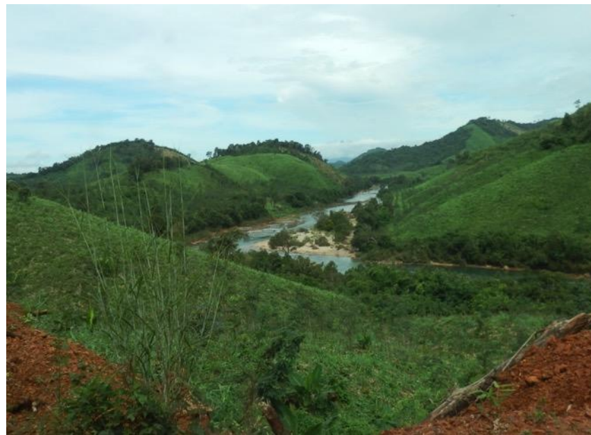
道路が通過する山間地
